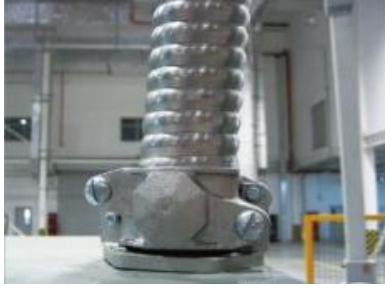
图 10 铠装电缆进入盘柜的套管保护
