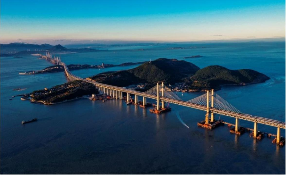
平潭海峡公铁大桥起于福建省福州市长乐区松下镇，经人屿岛、长屿岛、小练岛、大练岛，依次跨越元洪航道、鼓屿门水道、大小练岛水道、北东口水道，在苏澳镇上平潭岛，全长 16.34 公里。大桥下层为时速 200 km/h 的双线 I 级铁路，上层为时速 100 km/h 的六车道高速公路，是新建福州至平潭铁路、长乐至平潭高速公路的关键性控制工程，是合福铁路的延伸、京福通道的重要组成部分，是连接长乐副中心城市和平潭综合实验区的快速通道。
