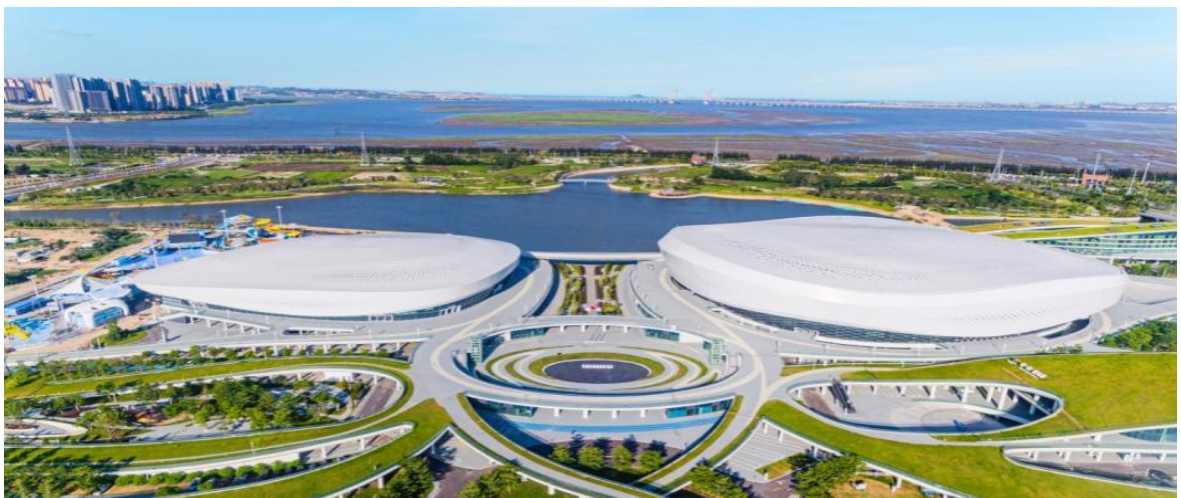
晋江市第二体育中心项目
