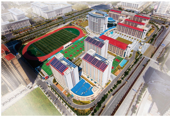
（鲁班奖）工程—泉州东海学园
