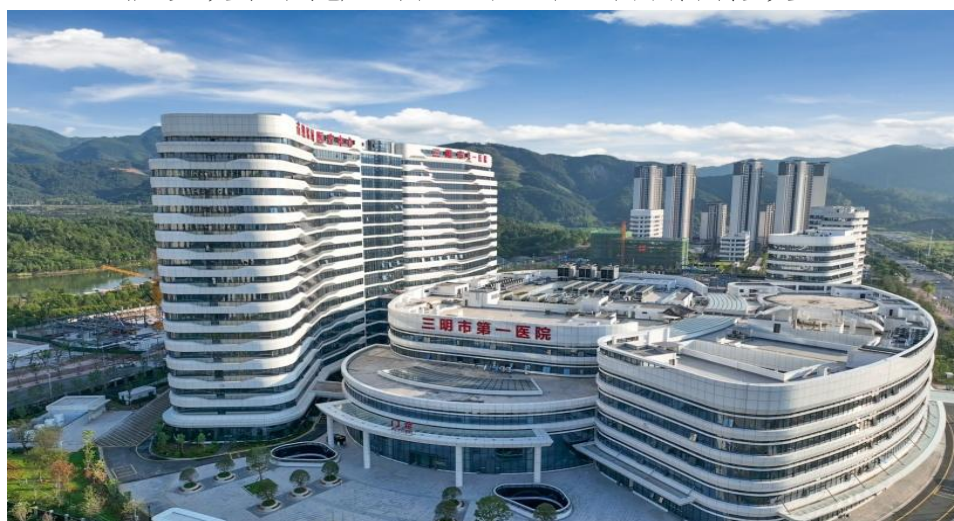
承建的三明市第一医院生态新城院区建设项目（建筑面积为 31.4 万平方）
