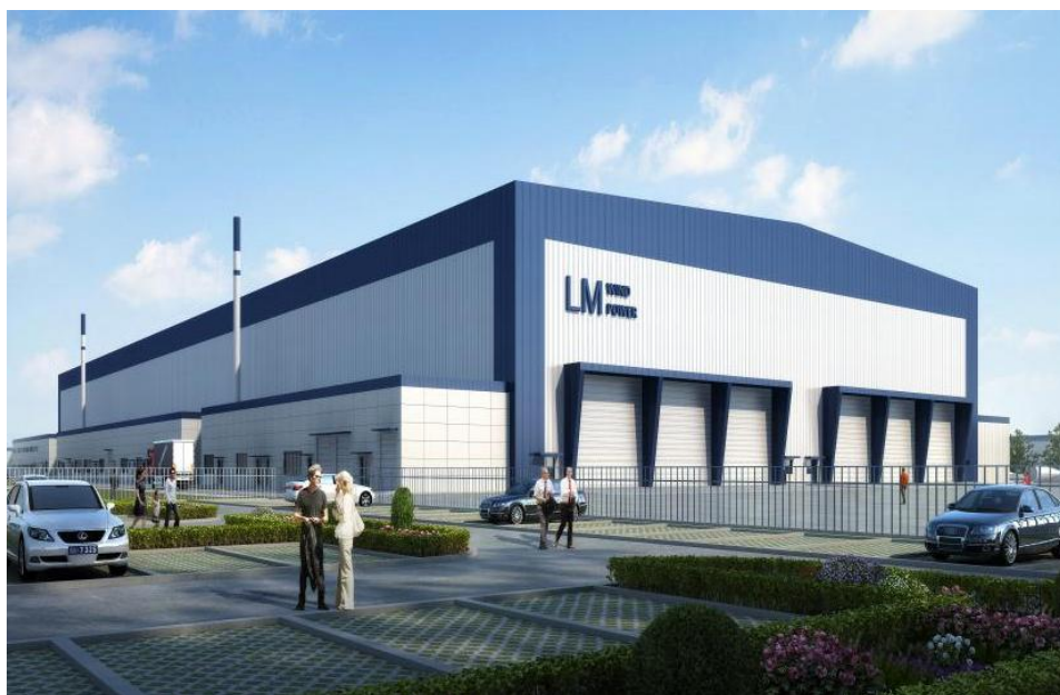
福建三峡海上风电产业园 LM 工厂工程（中国钢结构金奖）
