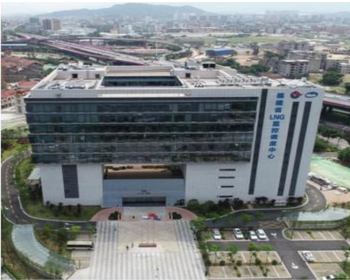
福建LNG 监控调度中心(全国优质工程—鲁班奖)
