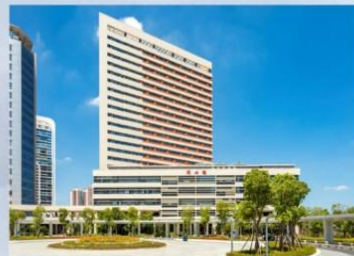
泉州市第一医院东城分院二期病房楼项目——荣获国家优质工程奖
