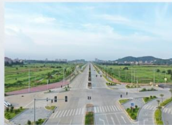
湄洲湾北岸荔港大道东吴段工程
