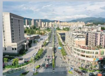
天马东路 (曹溪路-莲庄路)
