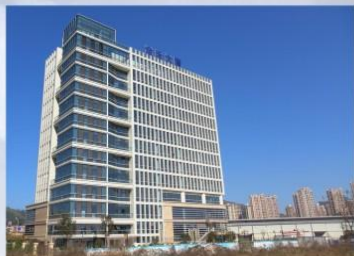
金禾大厦建筑工程项目——荣获福建省“闽江杯”优质工程奖
