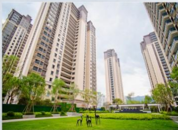
金禾·五福雅居建设工程项目
