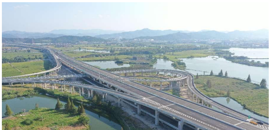
浙江杭绍台高速公路 2 标，合同造价 26.3 亿元
