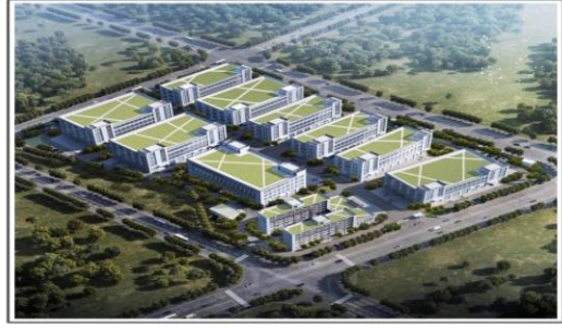
连城工业园区高新技术产业园建设项目一号厂区
