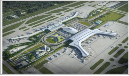
福州长乐国际机场二期扩建工程
